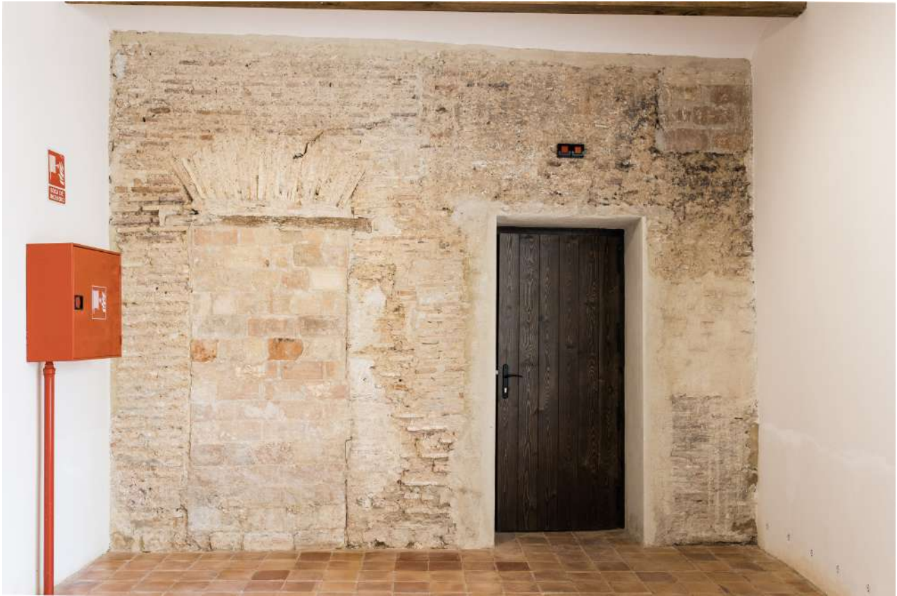
Img 31. Muro de tapial restaurado (Veritat.es)
