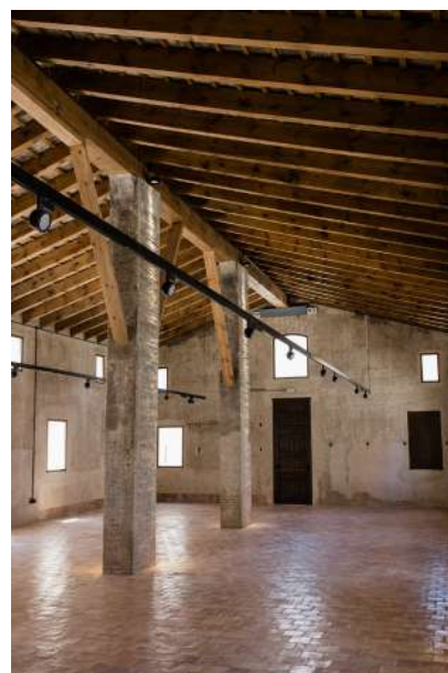
Img 20. Vista de la andana (Veritat.es)
