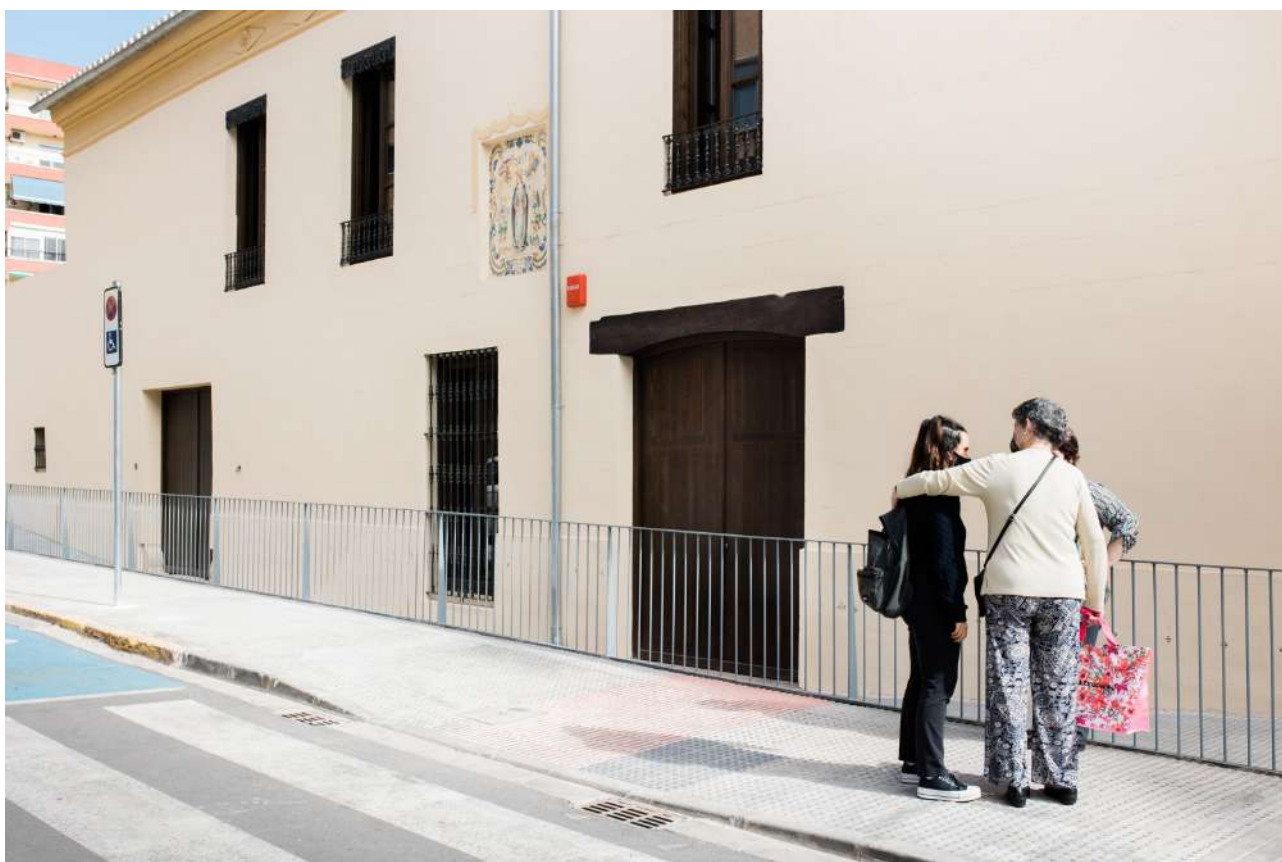
Img 48. Fachada sur de la Alqueria del Pí y acceso desde Carrer dels Furs (Veritat.es)
