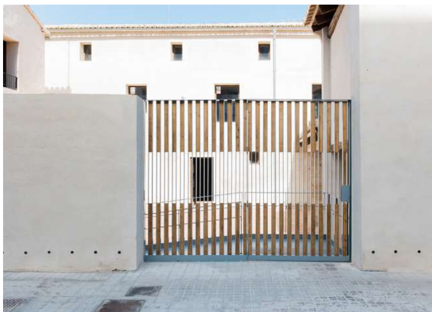
Img 19. Puerta al patio interior desde Avenida Blasco Ibáñez (Veritat.es)
