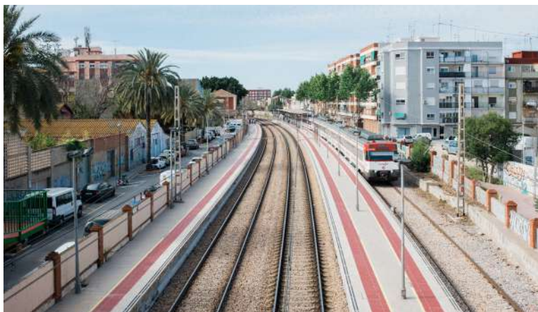
Img 3. Apeadero de Cercanías Alfafar - Benetússer (Veritat.es)
