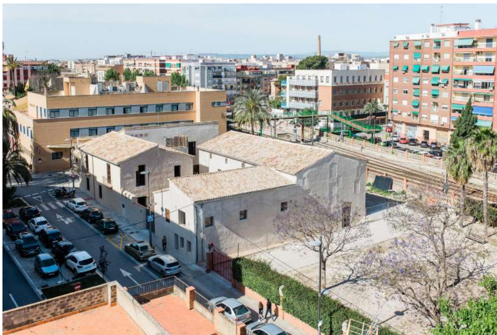
Img 17. Vista general de la Alqueria del Pí tras su rehabilitación (Veritat.es)
